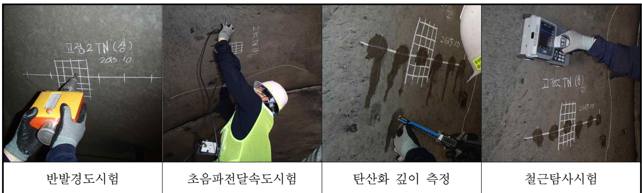
【사진 1.2.1】 콘크리트 내구성조사 전경
