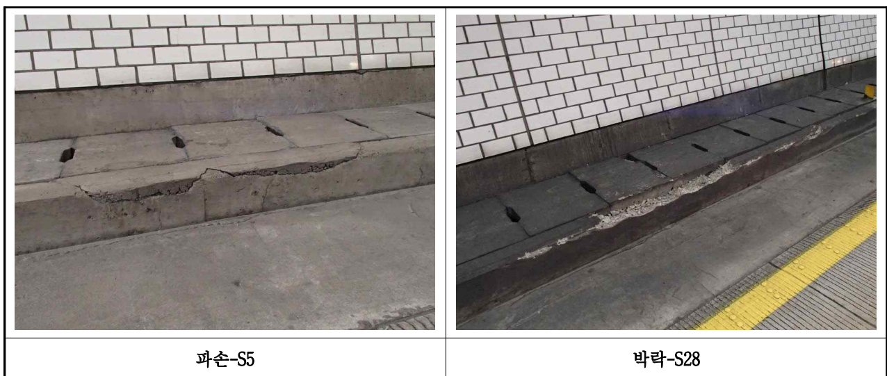
【사진 1.1.6】 공동구 외관조사 결과
