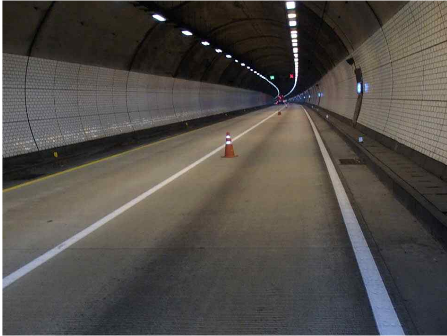
터널 내부 전경
