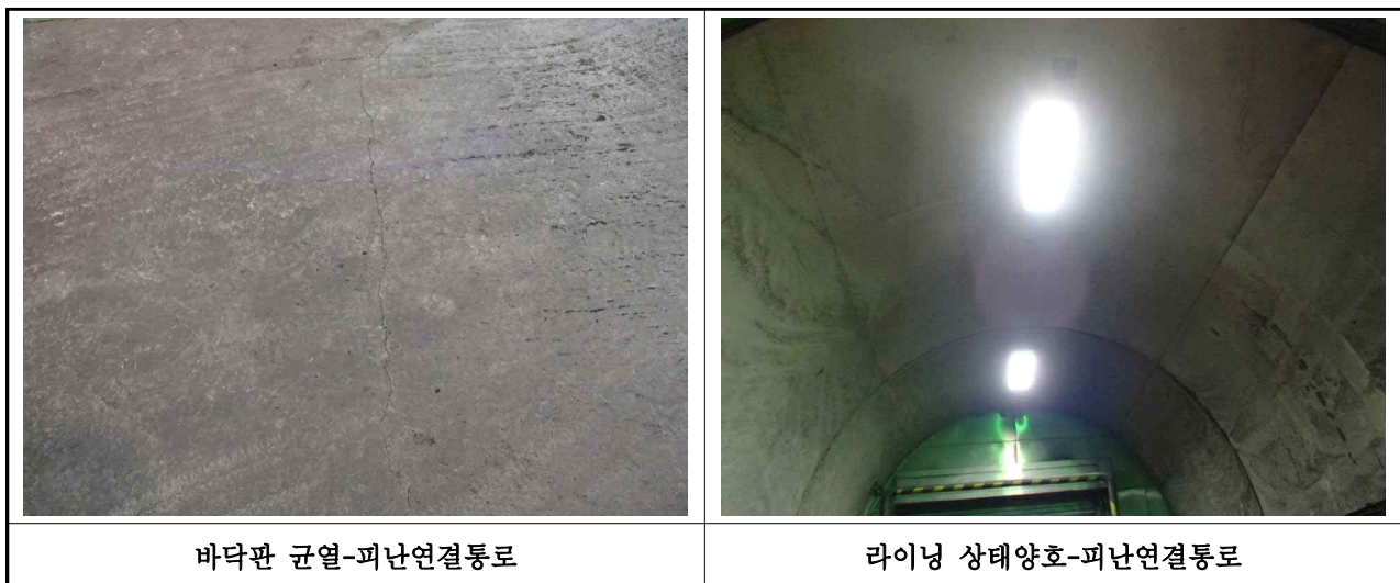
【사진 1.1.11】 피난 연결통로 외관조사 결과
