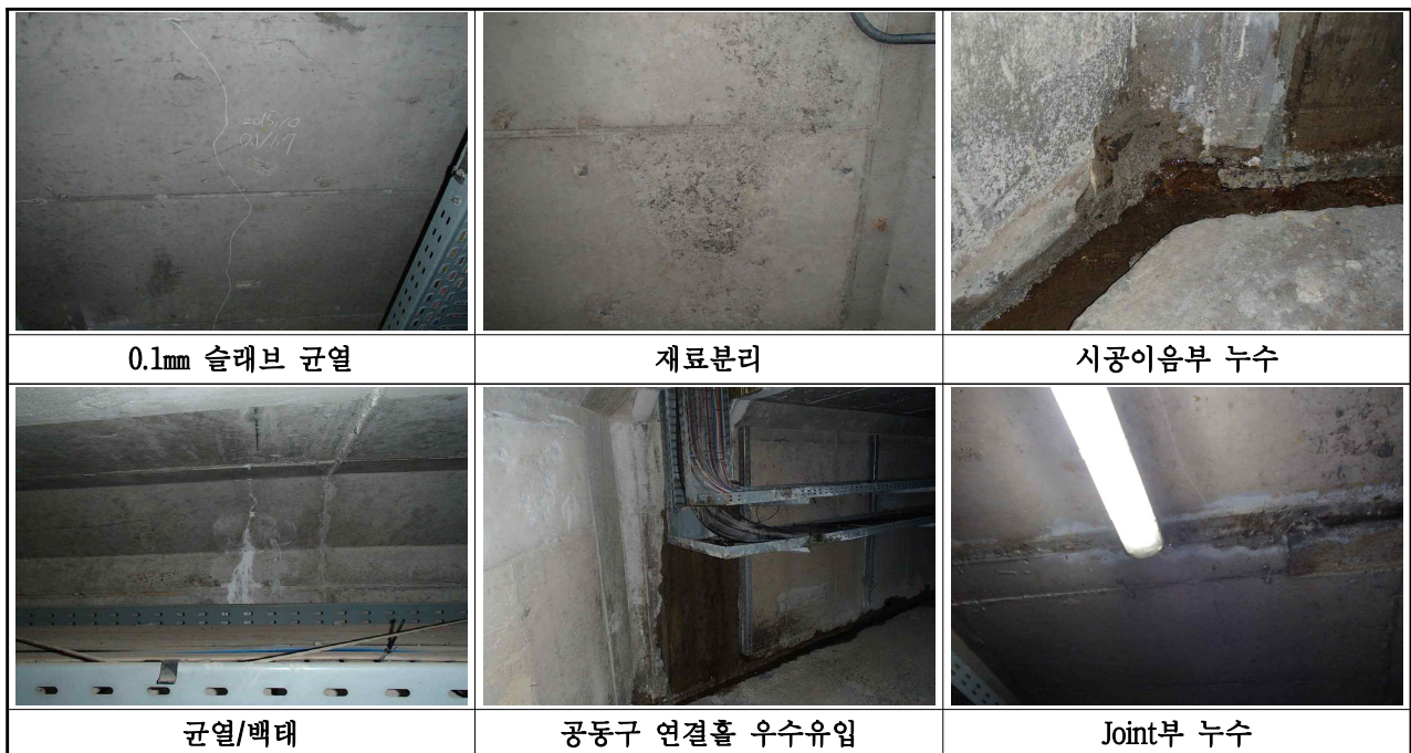
【사진 1.1.12】 옥외공동구 외관조사 결과
