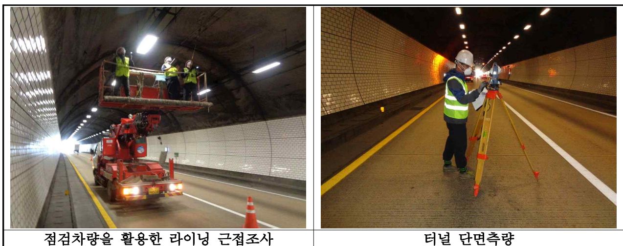
【사진 3.1.1】외관조사 전경
