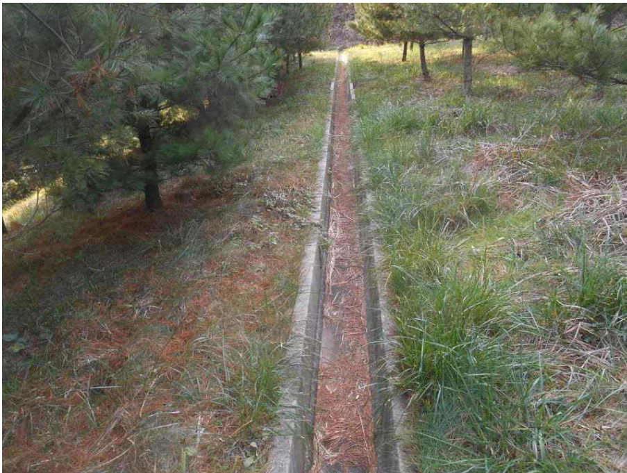
사면 배수로 전경
