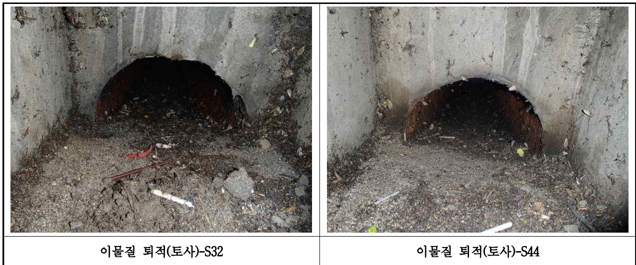
【사진 1.1.8】 배수시설 외관조사 결과
