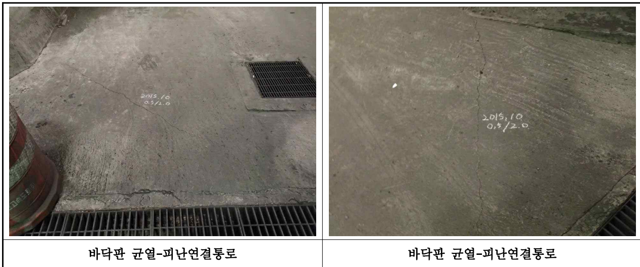
【사진 1.1.11】 부대시설 외관조사 결과
