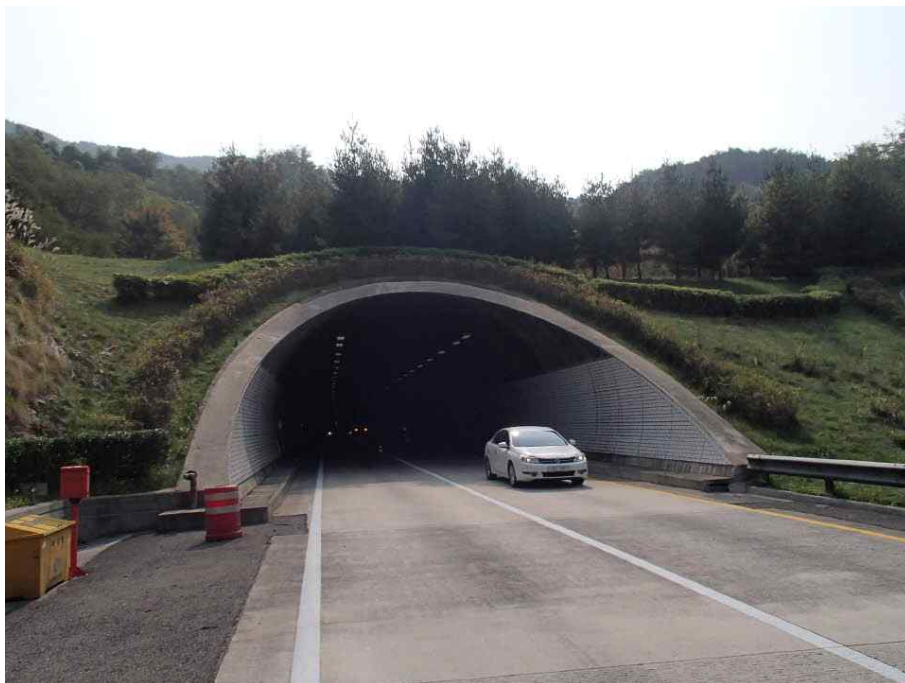
종점측 입구부 전경
