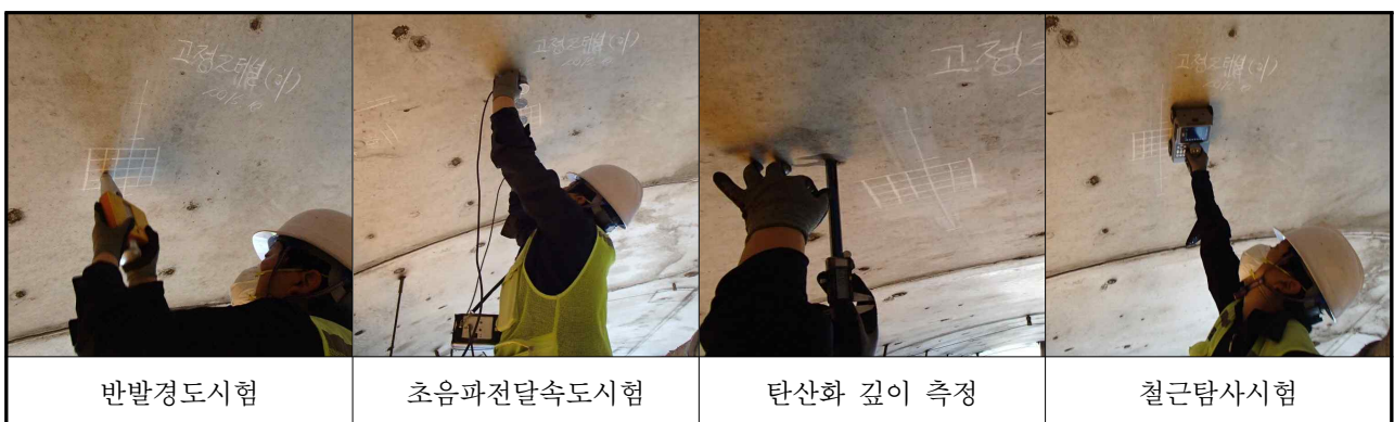
【사진 1.2.1】 콘크리트 내구성조사 전경
